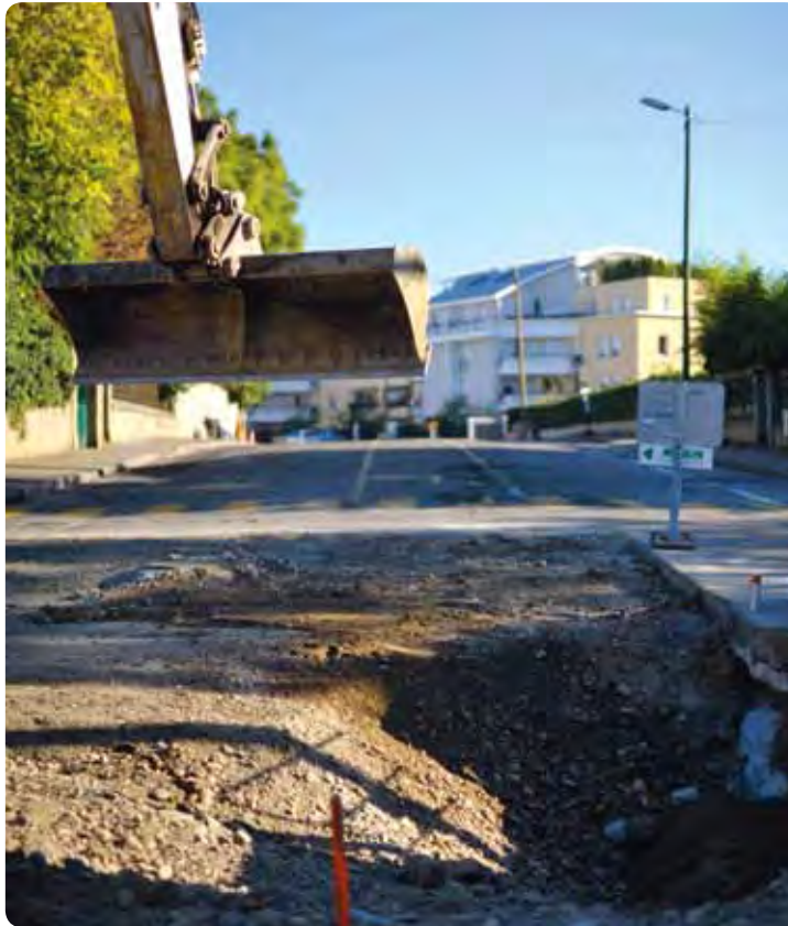
Travaux de voirie sur l'avenue De Lattre de Tassigny
