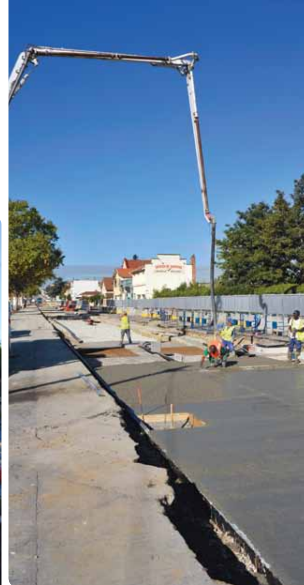
Travaux de plate-forme sur l'avenue François Mitterrand
